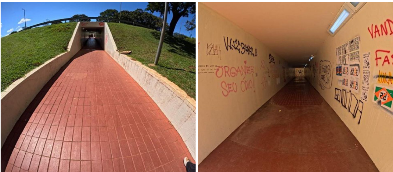
Figura 10. Imagens da passarela 407n em junho de 2023.
