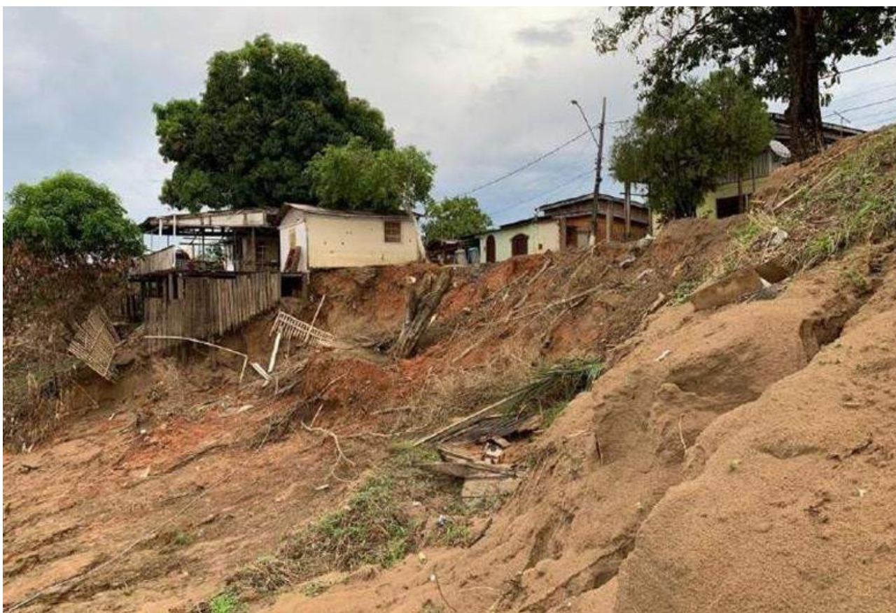
Figura 7. O colapso da margem. Margem do Rio Acre com destruição de barrancos e casas pela cheia.
